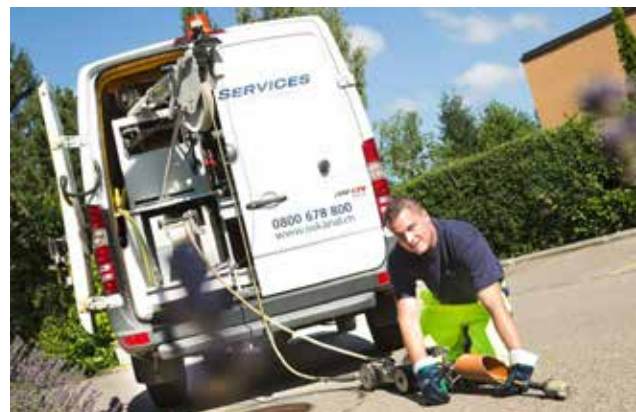
Spülvorgang von Entwässerungsleitungen im Untergrund
